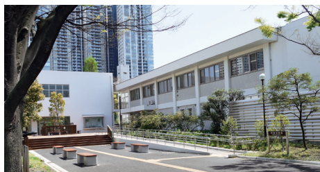
附属図書館（本館） University Library (Main Library)
