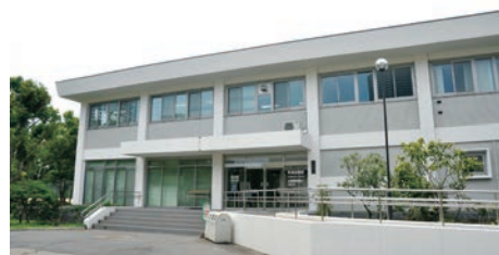
附属図書館（本館） University Library (Main Library)
