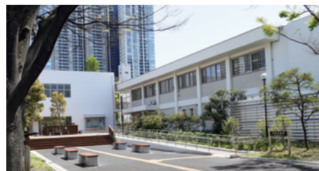
附属図書館（本館） University Library (Main Library)
