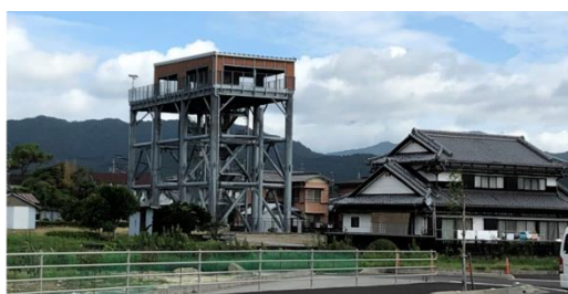
津波避難タワー
