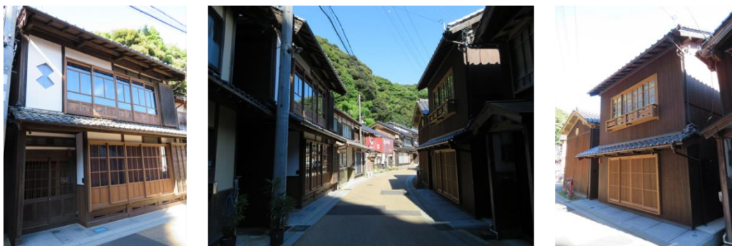
母屋と舟屋を改修した簡易宿所（鳥屋地区）
