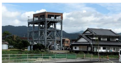
津波避難タワー
