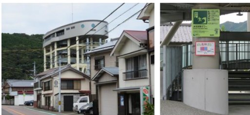
津波避難タワー
