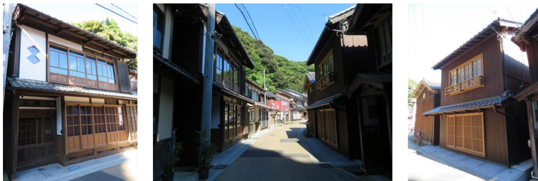
写真 1.3.5 母屋と舟屋を改修した簡易宿所（鳥屋地区）
