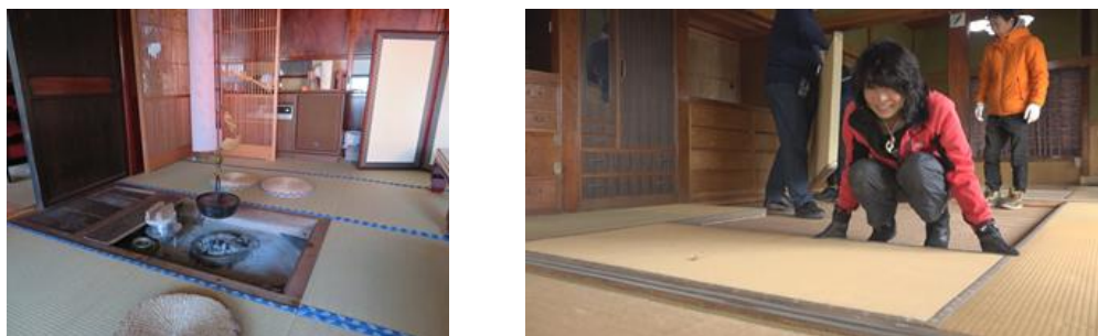
写真 2.3.2 古民家改修（DIY）
