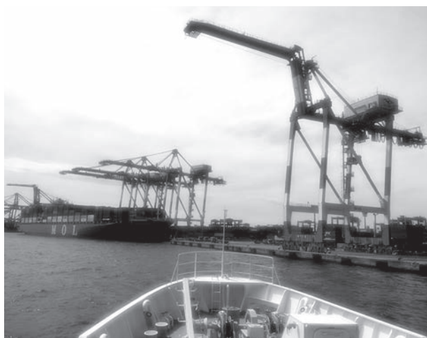
汐路丸から見たコンテナターミナル
