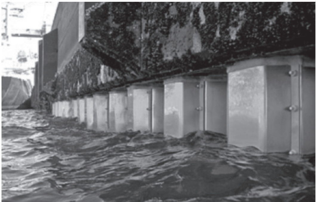
岸壁の下部構造（鋼矢板）に防食工事を行った際の様子
