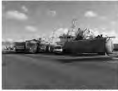
ハンストホルム港埠頭岸壁（デンマーク）
