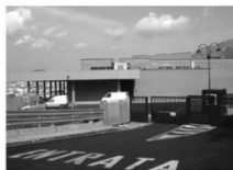
写真-17 改修中の魚市場
