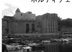
写真-18 改修中の廃墟
