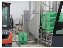
魚箱の洗浄・保管施設
