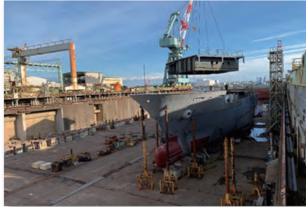
ブロック搭載 Erection block
