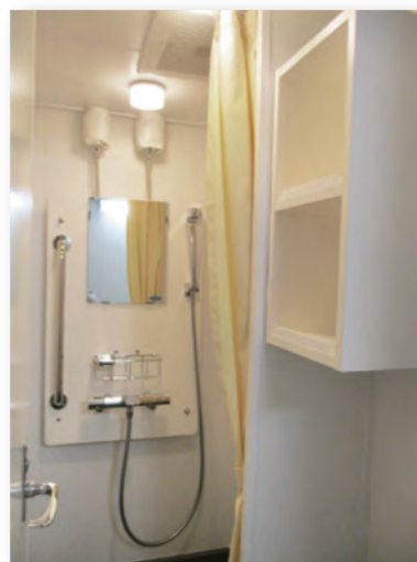
学生・教員シャワー室 Shower room
