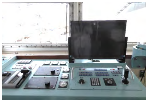
DP 操作パネル DP control panel
