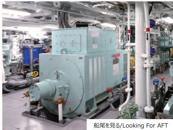
軸駆動発電機 Shaft Generator
