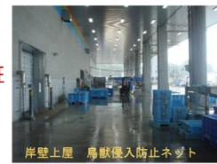
岸壁上屋 鳥獣侵入防止ネット
