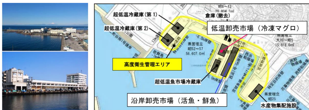
市場管理事務所・沿岸卸売市場
