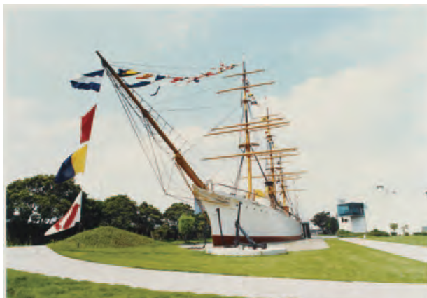
昭和63年撮影。現在は修復工事中。
