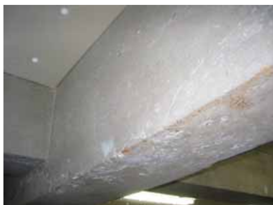
アスベスト撤去完了 (「撤去処理」され、天井には無害の断熱板を取付けました。)
