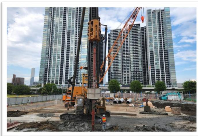
①工事の状況:重機による杭基礎工事(撮影日:R6.6.1)
