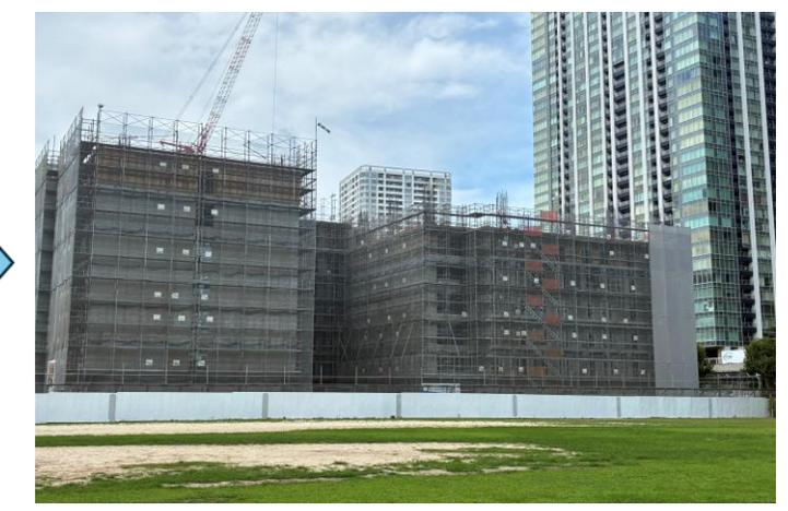
⑪工事の状況:7階型枠建込工事(撮影日:R7.6.26)
