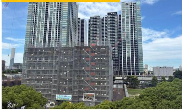
■工事の状況:7階梁・柱配筋工事
