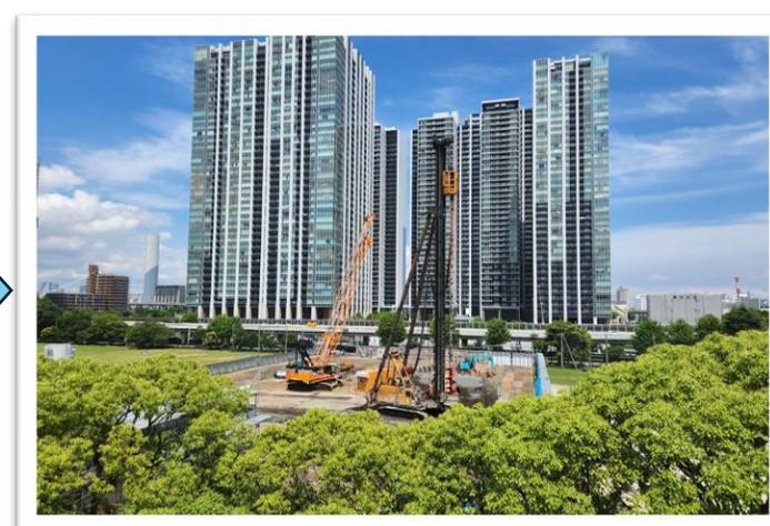
③工事の状況:重機による杭基礎工事(撮影日:R6.6.1)
