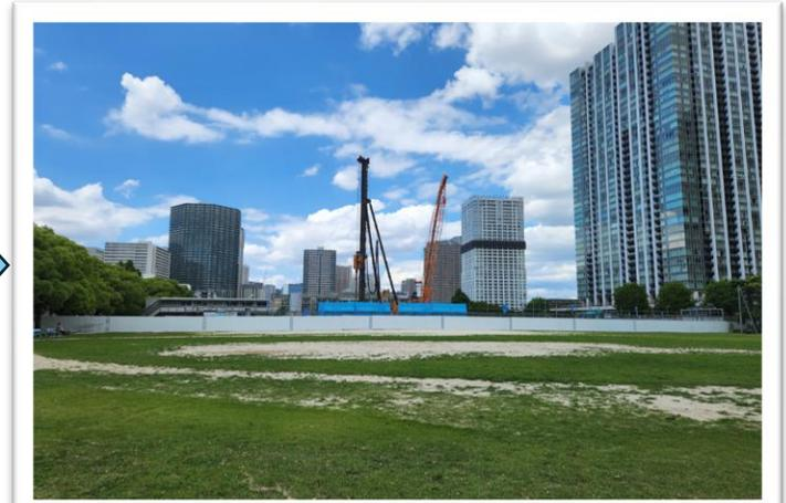
③工事の状況:重機による杭基礎工事(撮影日:R6.6.1)
