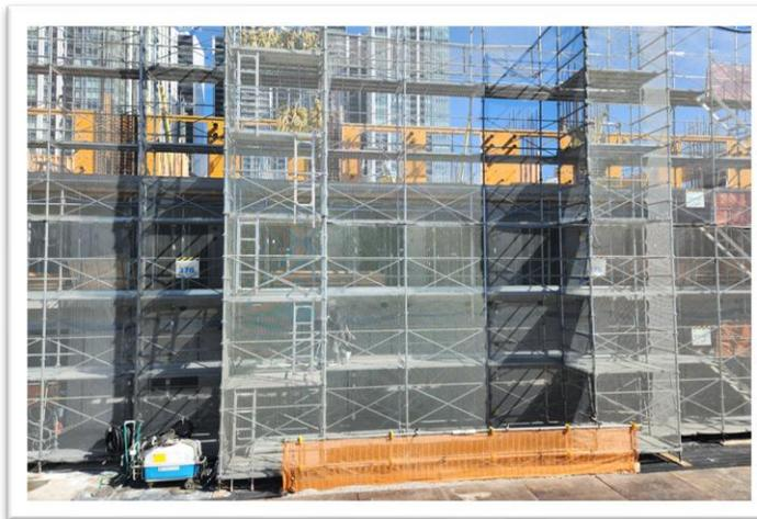
⑤工事の状況:2階梁・柱配筋,3階壁配筋工事(撮影日:R7.3.7)
