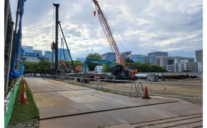
③工事の状況:重機による杭基礎工事(撮影日:R6.6.1)
