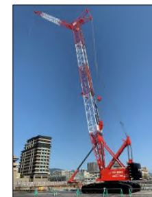
クローラークレーン
