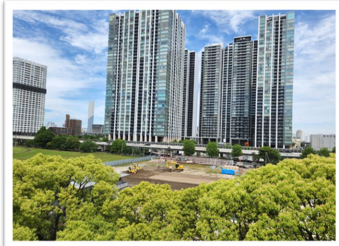
②工事の状況:重機による整地作業(撮影日:R6.5.14)
