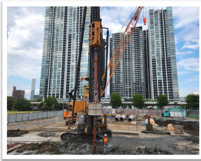
①工事の状況:重機による杭基礎工事(撮影日:R6.6.1)
