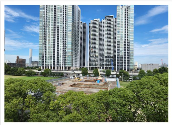
④工事の状況:山留工事(撮影日:R6.7.19)
