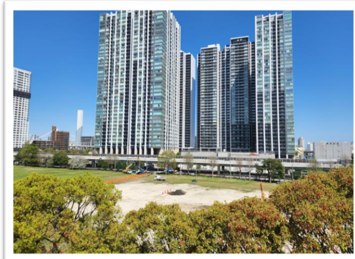
①工事の状況:準備工事/ネットフェンス設置による建設予定地の仮囲い(撮影日:R6.4.8)
