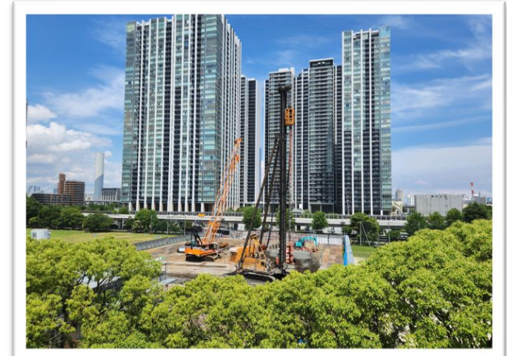
③工事の状況:重機による杭基礎工事(撮影日:R6.6.1)
