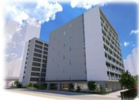
【外観①】北西方面から見た建物
